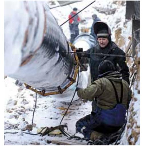
Сварочные работы на входном газопроводе
